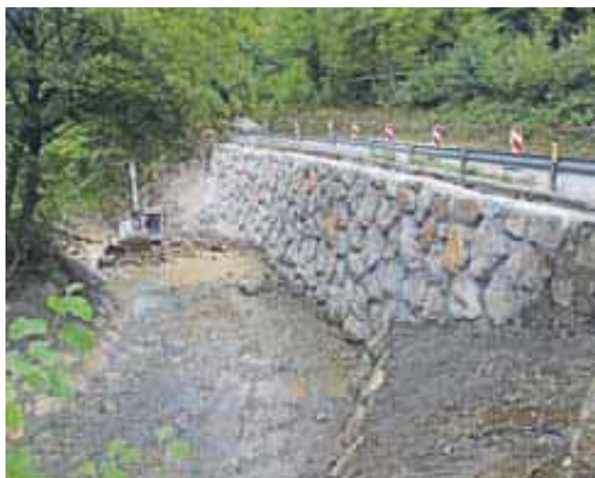
Gradnja podpornega zidu je bila nujna, saj se je vozišče na tem delu že močno posedlo.
